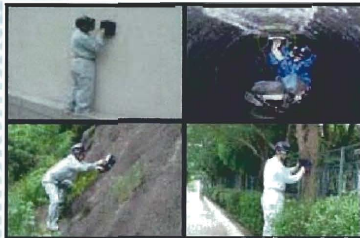
レーダ探査状況
