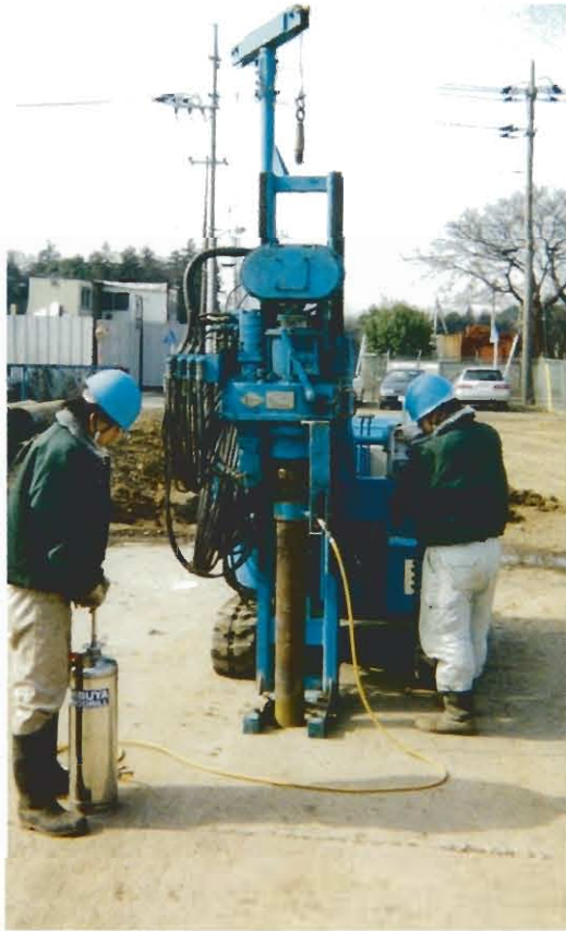
口元掘削状況
